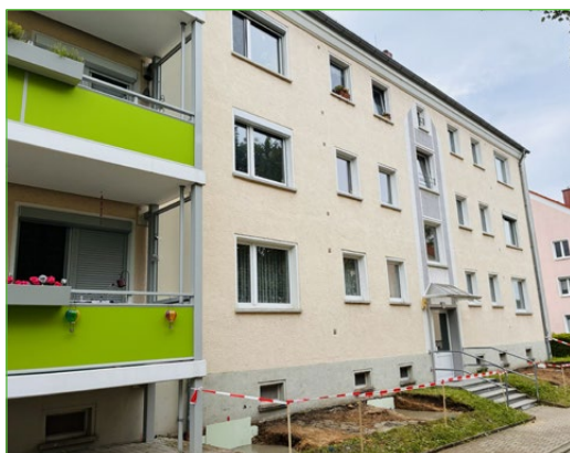
Balkonanbau in der Geußnitzer Straße 43.
